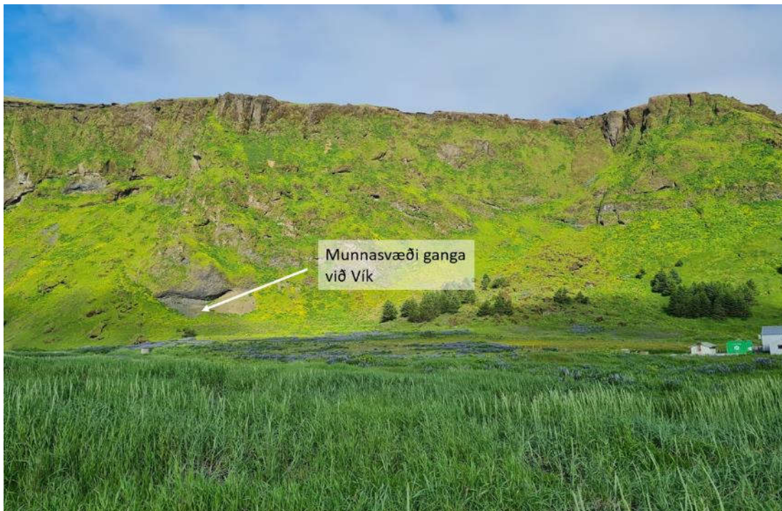
Mynd 6: Gangamunni við fjöruna í Vík er í kubbabergseitli til vinstri á myndinni. Annar lítill eitill er hægra megin við væntanlegan gangamunna. Efst í fjallinu er vel samlímt móbergstúff
